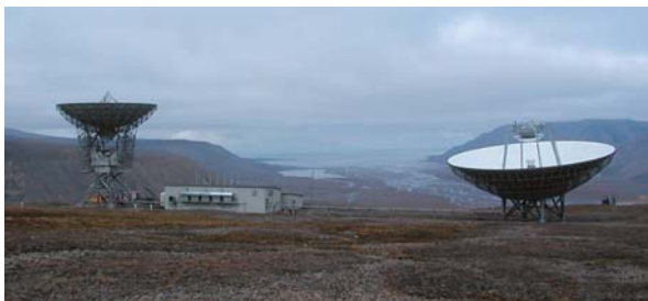
図3 EISCAT スヴァールバルレーダー (ESR)。右側が口径42 mの沿磁力線固定式アンテナ、左側が口径32 mの可動式アンテナ。
