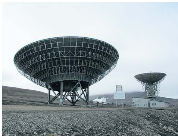
写真2 同一方向に向けたスヴァールバルISレーダーの2つのアンテナ。手前は直径42m、向こう側は32mのアンテナ。
