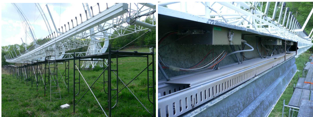
図3 木曾アンテナへの低雑音受信機 FE327-V5 の組み込み作業
