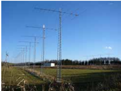
図 5. 北海道・陸別観測所に建設された SuperDARN 北海道短波レーダー。
